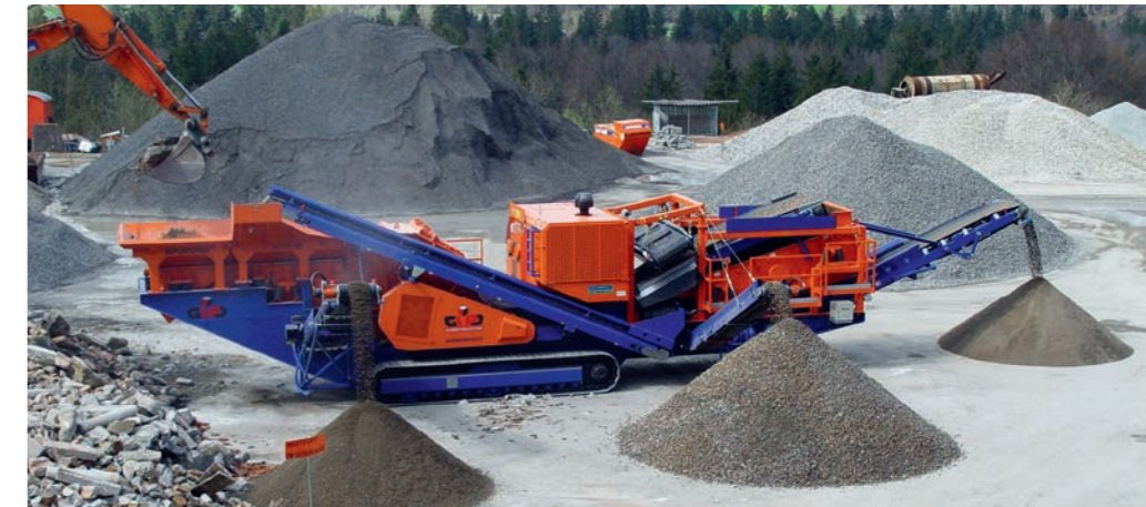
Brechen und Sieben auf einer Anlage
