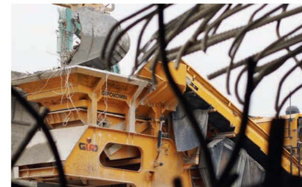
Komplette Materialaufbereitung direkt beim Abbruchobjekt
