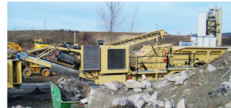
R 130 FDR Einsatz im stark armierten Betonabbruch
